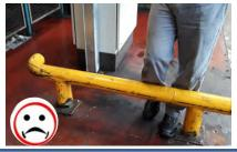
Ajustement de la longueur de l'anticar par rapport à la zone de dépotage, mise en place d'une main courante.
