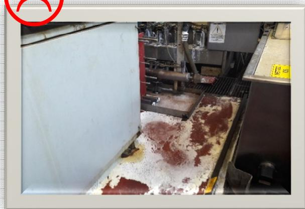
Les rétentions et encuvements sous machines doivent être vides.
